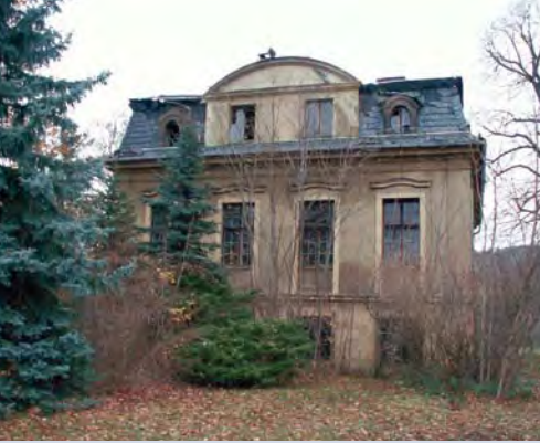
Die Villa nach dem Brand Foto: Landeshauptstadt Dresden
