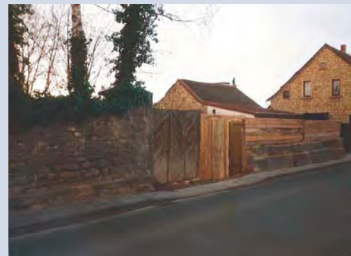
Vor, während und nach Abriss Fotos: Stadt Ingelheim
