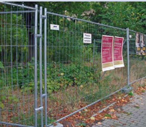
Zugewuchertes Grundstück (oben und Mitte) und Sicherung durch Bauzaun Fotos: Stadt Dresden
