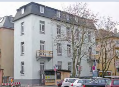
Instandhaltungs- und Sanierungsrückstau (oben und Mitte) und das Gebäude nach der Sanierung
